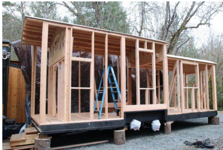
Figura 2 - Estrutura da Tiny House
